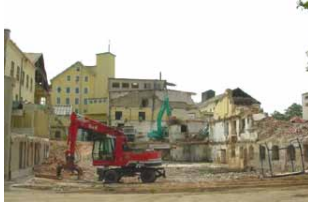
Demolition of obsolete districts Démolition de quartiers obsolètes
